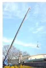
空調資材搬入の様子
