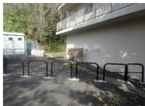
チンパンジーバックヤード前施工後
