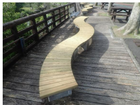
白鳥池ベンチ修繕後
