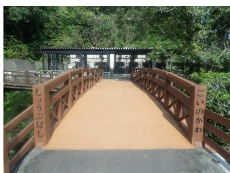
しょうぶ橋修繕後
