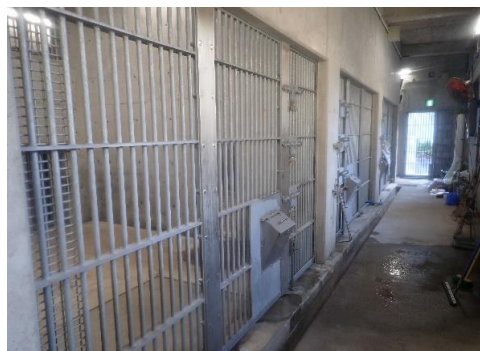
ライオン舎寝室施工前
