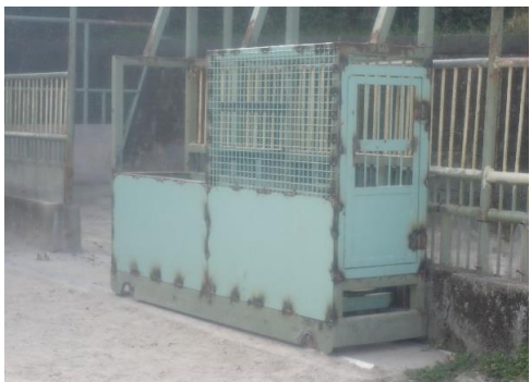
キリン舎扉施工後
