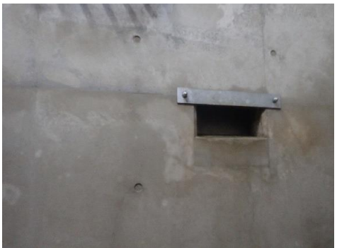
トラ寝室餌投入口施工前
