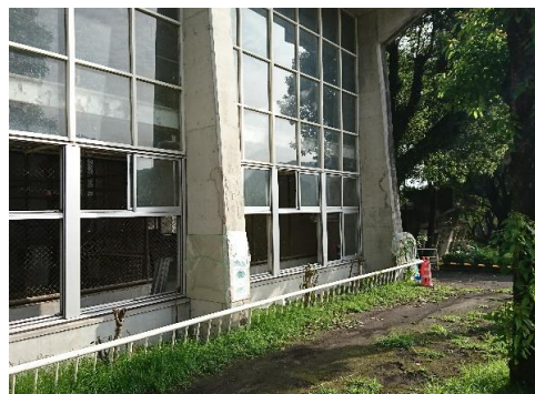
キリン舎コンクリート修繕後
