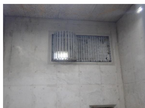
ライオン舎寝室のぞき窓施工後
