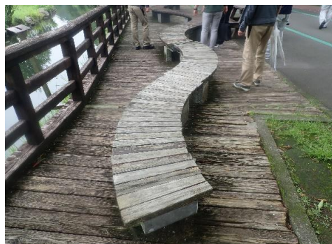
白鳥池ベンチ修繕前
