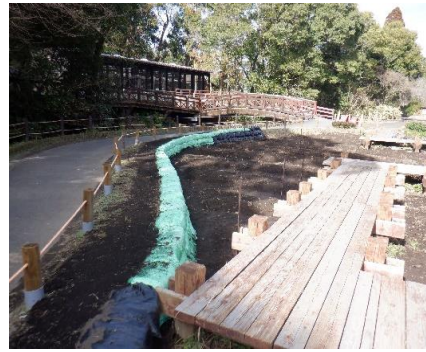
水漏れ補修後
