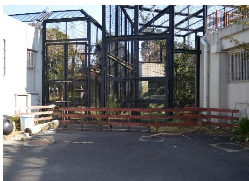
ライオン・ヒョウバックヤード施工前
