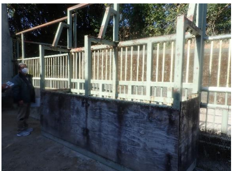
キリン舎扉施工前
