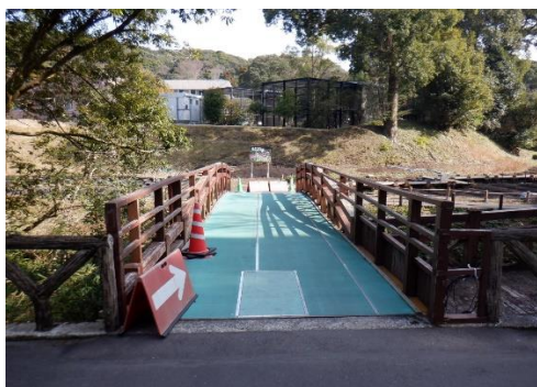
しょうぶ橋修繕前
