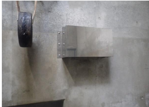
トラ寝室餌投入口施工後
