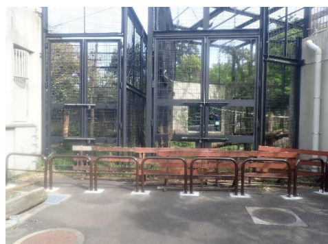
ライオン・ヒョウバックヤード施工後
