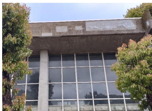
キリン舎コンクリート修繕後
