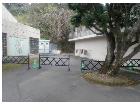
チンパンジーバックヤード前施工前
