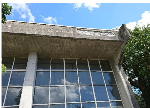
キリン舎コンクリート修繕前
