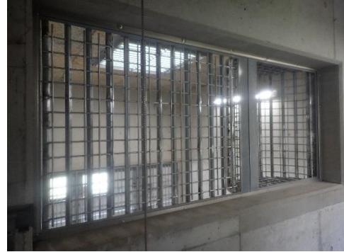
ジャガー寝室のぞき窓施工後
