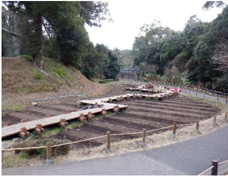
水漏れのある圃場
