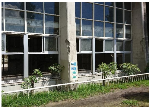
キリン舎コンクリート修繕前
