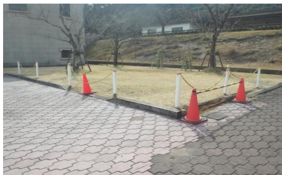
枕木の腐食状況
