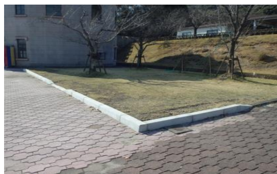
コンクリートブロック設置
