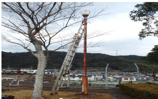
劣化により使用不能な外灯
