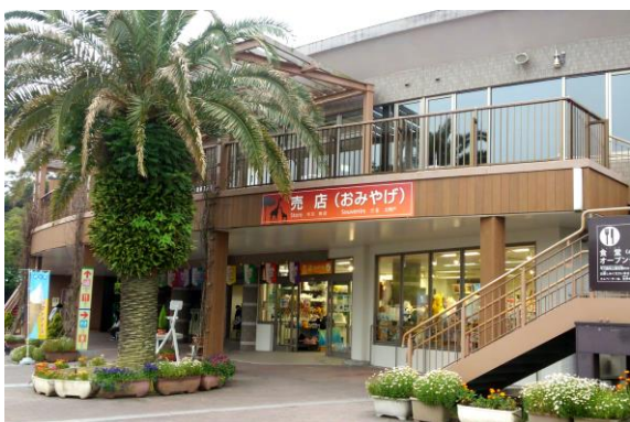
増築したゲート前売店（外観）
