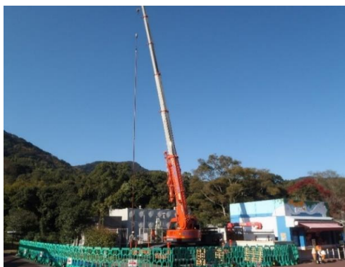
引き上げ状況
