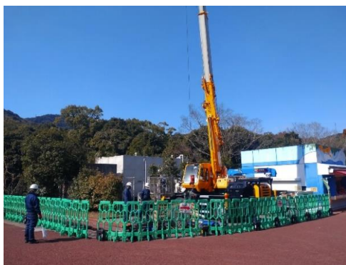
ポンプ引き上げ状況①
