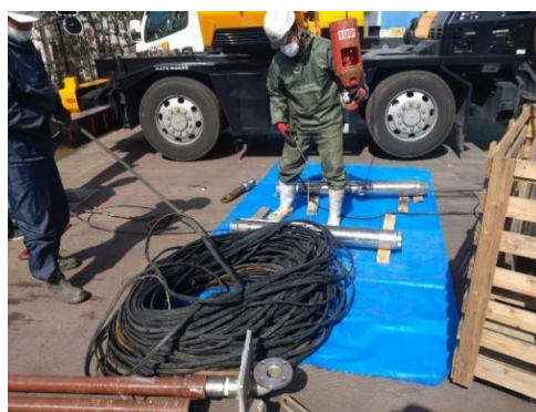
ポンプ引き上げ状況②
