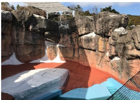
遮光ネット設置状況
