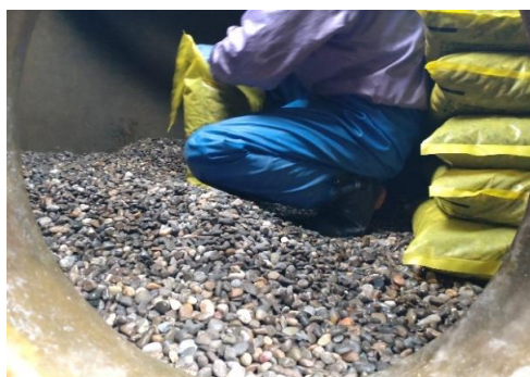
ろ材取替状況
