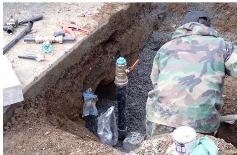
配管エンドキャップ取替
