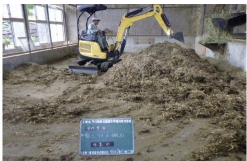
キリン舎寝室敷き土搬出
