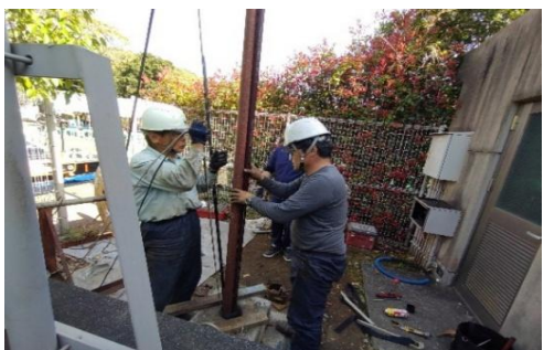
揚水管引き揚げ
