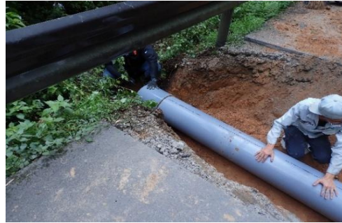
新しい浸透管の設置
