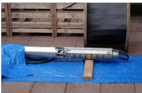
引き揚げられた深井戸ポンプ
