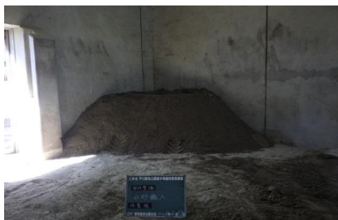
ゾウ舎寝室 山砂搬入 c 台風被害復旧
