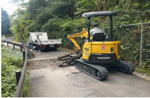
修繕工事の様子
